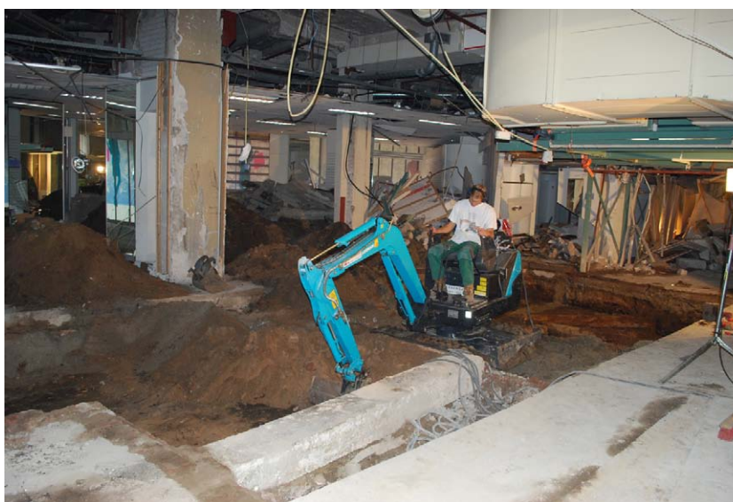
Afb. 3.1 Het proefsleuvenonderzoek werd inpandig uitgevoerd met een elektrisch aangedreven minikraantje.
