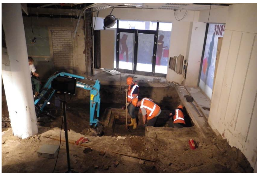
Afb. 3.2 Impressie van het veldwerk tijdens het proefsleuvenonderzoek.
