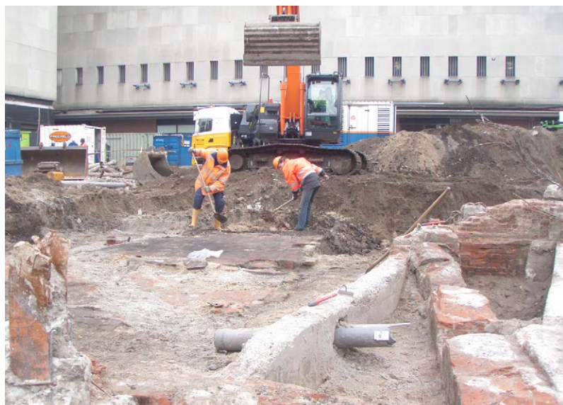
Afb. 3.4 Bij het aantreffen van muren en vloeren werd het graafwerk met de schep voortgezet.
